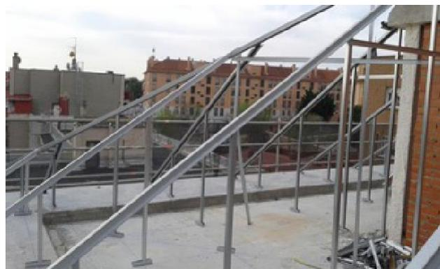
El estudio de las estructuras ligeras se basa en una precisa estructura espacial de barras de acero o aluminio que trabajan a tracción y compresión, con las condiciones de rigidez necesarias. Su unión está formada por perfiles tipo C, U y Omega, mediante soldadura o atornillado.
