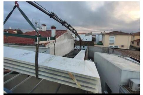
Con el objetivo de seguir innovando y ofreciendo el mejor servicio a nuestros clientes, hemos incorporado un servicio de elevación mediante ventosas, tanto para paneles de cubierta como de fachada. Capaz de colocar los paneles tanto en horizontal como en vertical, adaptándose a las irregularidades de la superficie del panel y garantizar un excelente agarre. Cuenta con capacidad de hasta 400 kg.
