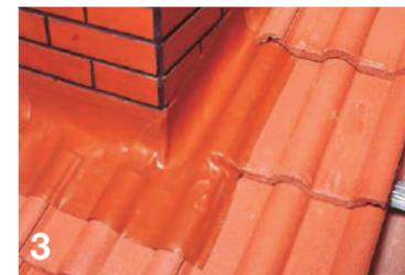
3 Detalle de unión de bandas impermeables multiuso.
